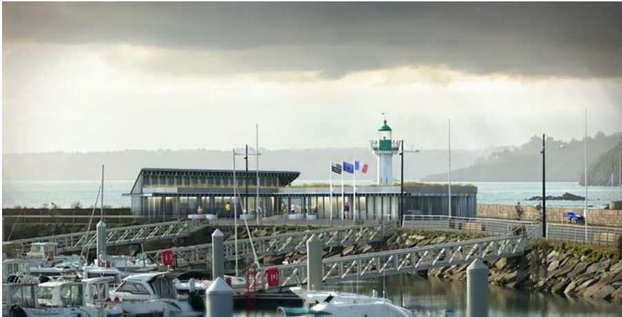
Construction d'une maison du Port (sanitaires et services), pour le Syndicat Mixte de Saint Quay Portrieux Port d'Armor, Coût : 1 M€ Architecte mandataire : Dominique BONNOT
